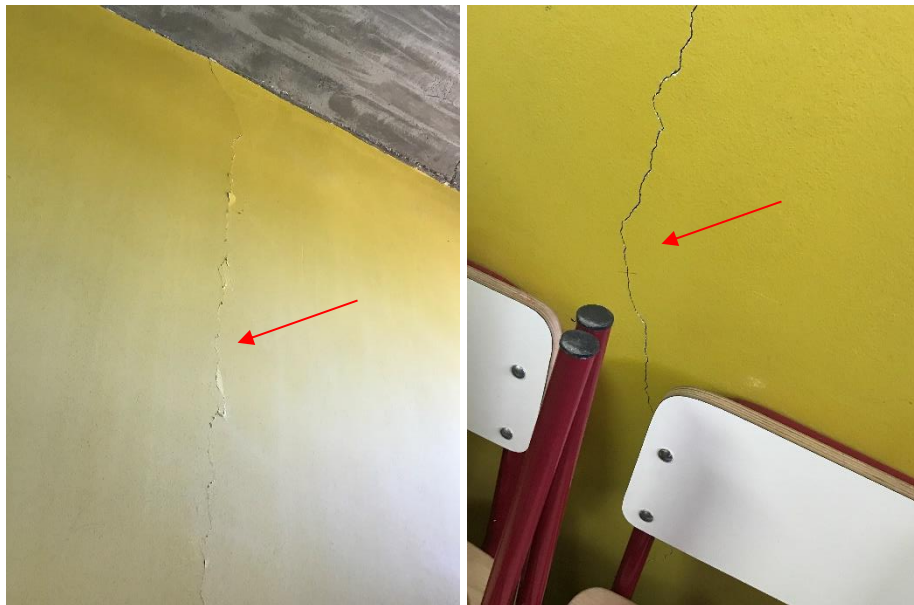
Planta alta vista interior muro que mira junta de dilatación sector oeste. Se repiten los patrones de fisuras de planta baja.
