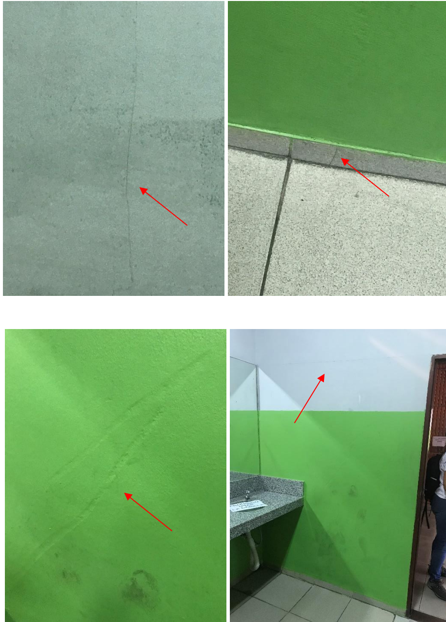
Planta baja vista interior muro que da al corredor Vestigios de reparaciones.
